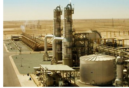
مشروع بابلوت للغمر بالبخار في حقل الوفرة- أنتج خام ثقيل بمستويات تعادل معدلات الإنتاج الأولية ست مرات
