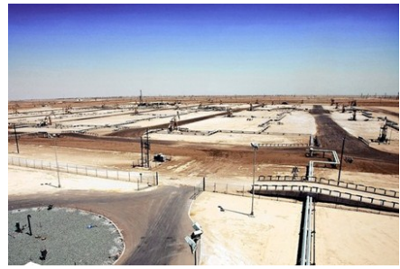
أنابيب تنقل البخار إلى الحقل، الذي يتم حقنه في باطن الأرض لتخفيف النفط الثقيل ليسهل ضخه إلى سطح الأرض
